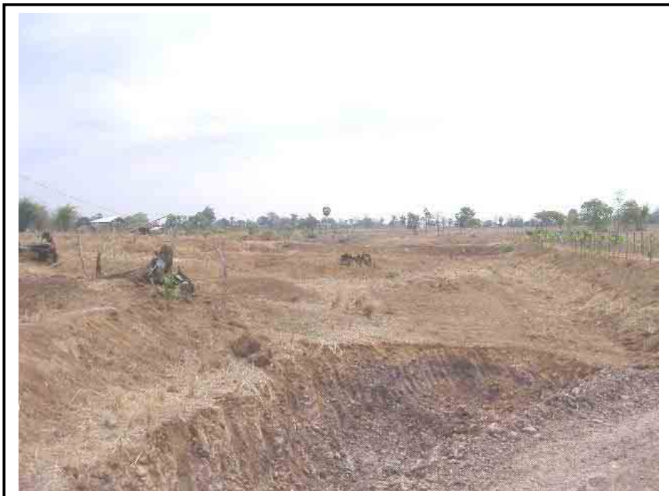
จุดถ่ายภาพที่ 9 : สภาพภายในที่ดิน
